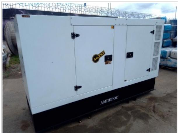
Дизель генератор мощностью 130 кВт/143 кВт в шумозащитном кожухе. Дизель Iveco-FPT (Италия) 1500 об/мин жидкостного охлаждения. Дизель генератор для интенсивной эксплуатации.
