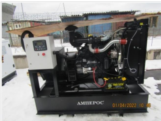
Дизель генератор мощностью 100 кВт/110 кВт. Дизель IVECO-FPT(Италия) 1500 об/мин жидкостного охлаждения. Дизель генератор для интенсивной эксплуатации.
