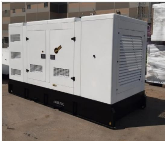
Дизель генератор максимальной мощностью - 495 кВА/400 кВт, основная мощность 450 кВА/360 кВт. Дизель KÖGEL 1500 об/мин 6-цилиндровый.
