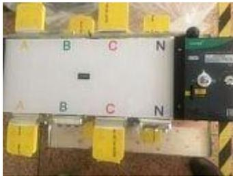
**Реверсивный рубильник-переключатель с моторприводом 2500А**
