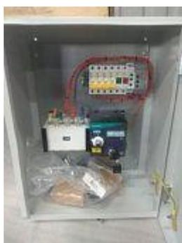
**Автоматический коммутатор нагрузки 630А**
