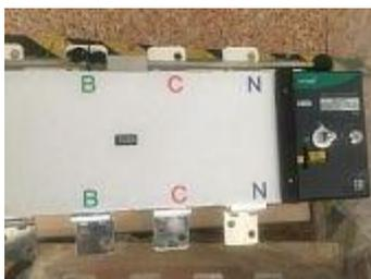
**Реверсивный рубильник-переключатель с моторприводом 1000А**
