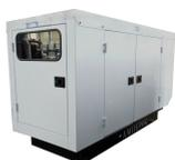
**Дизельный генератор АМПЕРОС АД 25-Т230 в кожухе с АВР**
