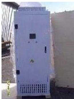
**Автоматический коммутатор нагрузки 2500А**
